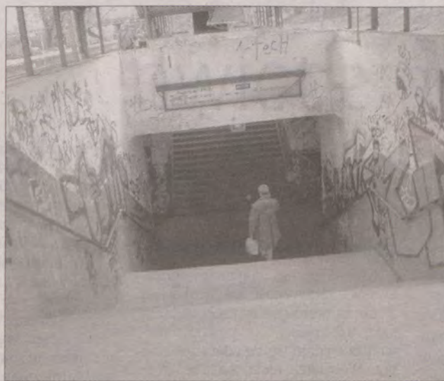
Teraz wieczorami w przejściu podziemnym powinno być jasno. Wygląd tunelu i całego dworca to już osobny problem.
