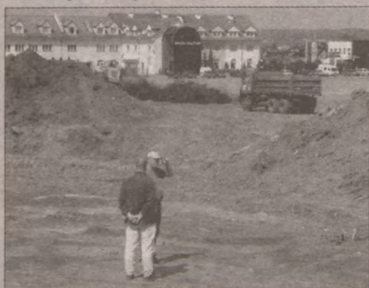
Na placu przed „Faltomem” ruszyła budowa.
