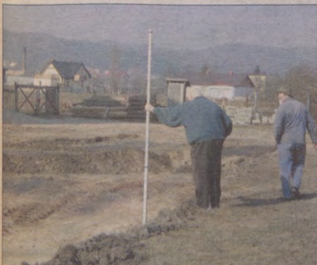
Pierwsze wykopy pod budowę kościoła.
