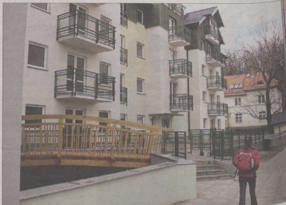
W budynku przy ul. Malczewskiego 5B zamieszka dzisiaj 21 rodzin.
