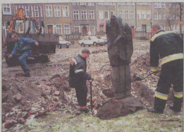
Nowe inwestycje pojawią się najpierw w sercu miasta. Na placu przy ul. św. Ducha już trwają prace przygotowawcze.
