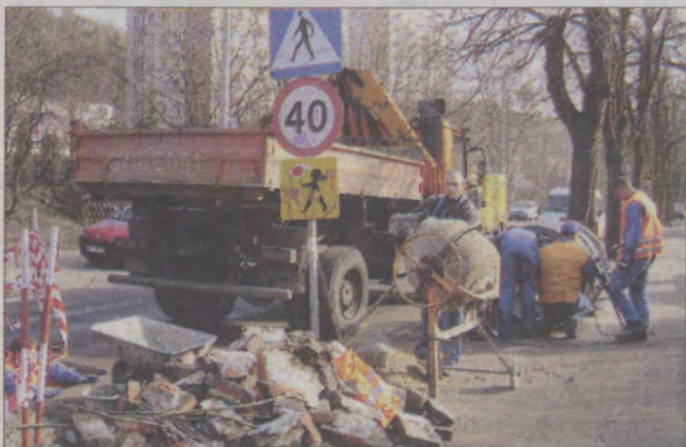
Trwa remont studzienek wodno-kanalizacyjnych przy ul. 23 Marca w Sopocie.
