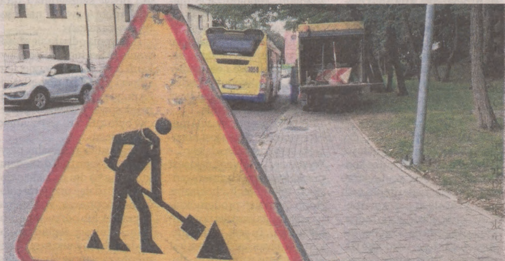
Remont chodnika po północnej stronie ulicy Obrońców Wybrzeża
