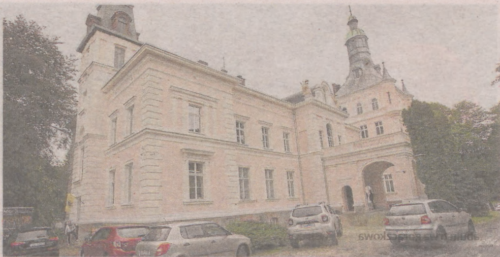
Pałac w Damnicy to okazały budynek z drugiej połowy XIX wieku. Po remoncie elewacji odzyskał dawny blask
