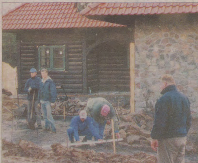
Jeszcze trzy-cztery dni przed otwarciem teren centrum był jednym wielkim placem budowy.
