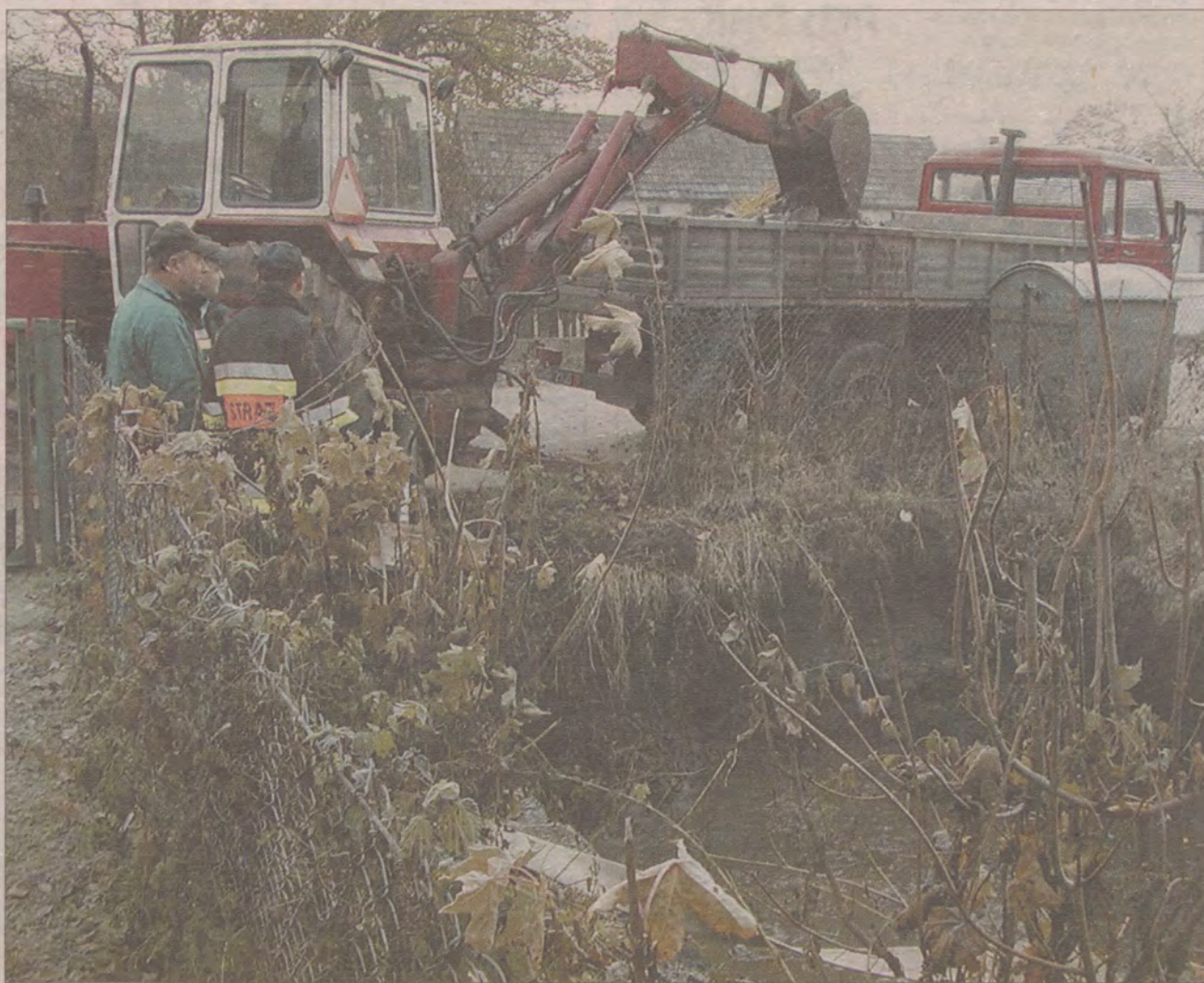
W Węsiorych już oczyszczono i pogłębiono zbiorniki, które mają gromadzić porztopową i opadową wodę.
