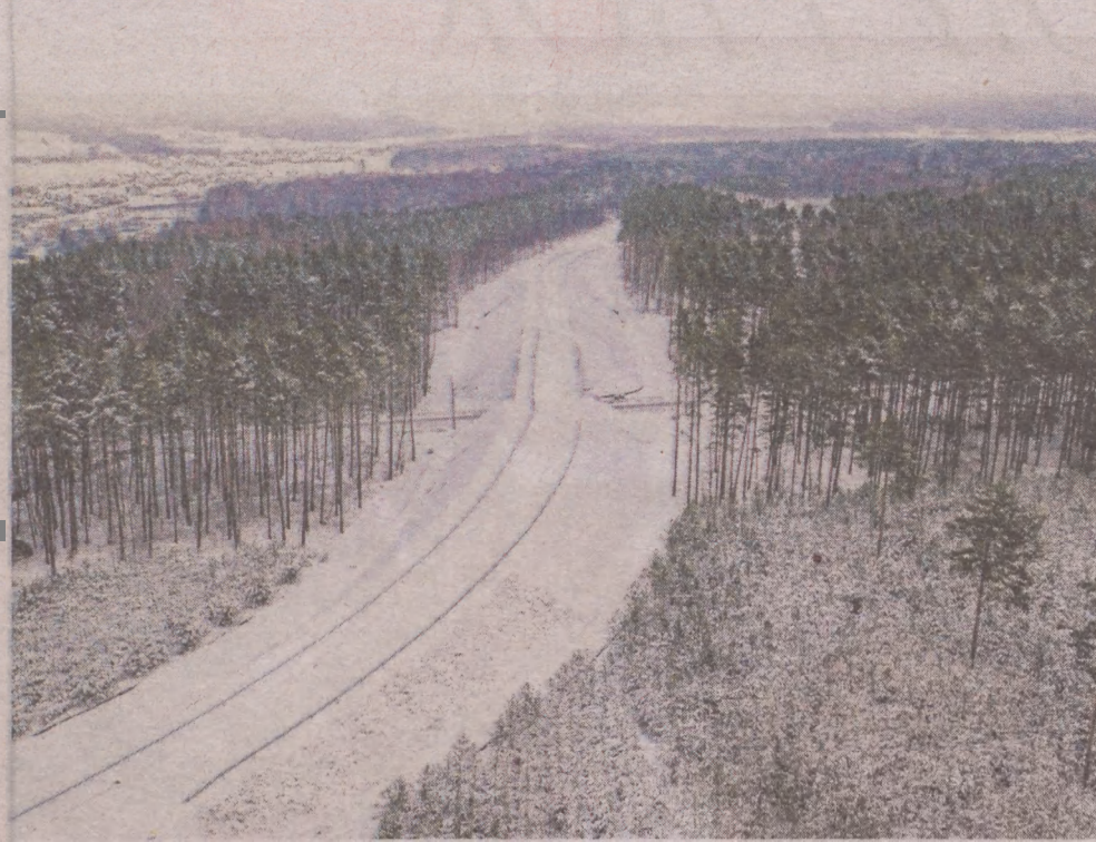
W zaawansowanej budowie, choć z opóźnieniem jest Trasa Kaszubska, czyli S6 między Bożympołem Wielkim a Gdynią. Otwarcie latem 2022 roku
