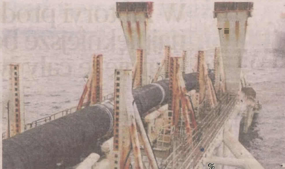
Specjalistyczne statki układają rury na dnie Bałtyku
