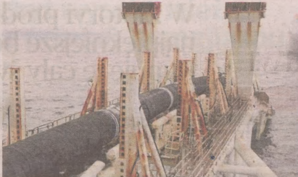
Specjalistyczne statki układają rury na dnie Bałtyku
