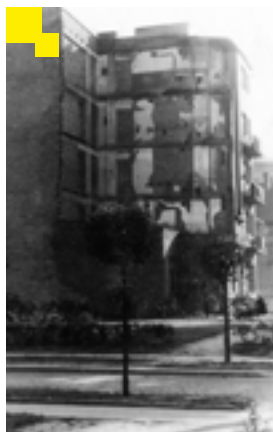
Wojenne uszkodzenia kamienicy, 1946 rok. Zbiory rodziny Ciara-Henicz
