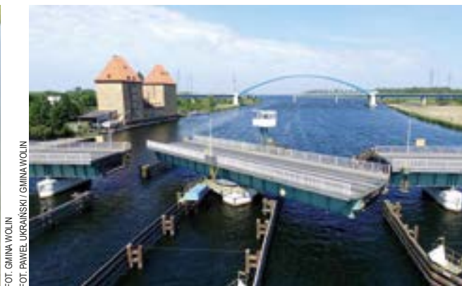
Most obrotowy na cieśninie Dziwnie.
