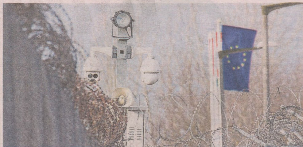
Zapora na granicy węgiersko-serbskiej: ogrodzenie z drutu kolczastego wspomagane przez system kamer
