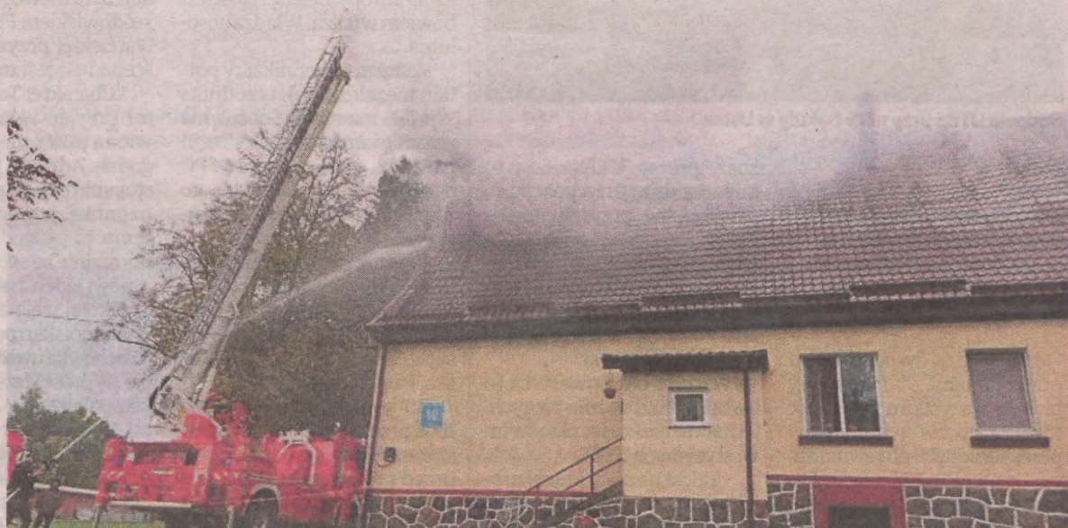
Niestety, jedna osoba straciła życie. Część budynku będzie rozebrana. Uszkodzeniu uległy także stropy. Powiatowy inspektor nadzoru budowlanego w powiecie słupskim wyłączył budynek z użytkowania
