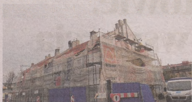
Budowa UTBS przy ulicy Bakuły w Ustce
