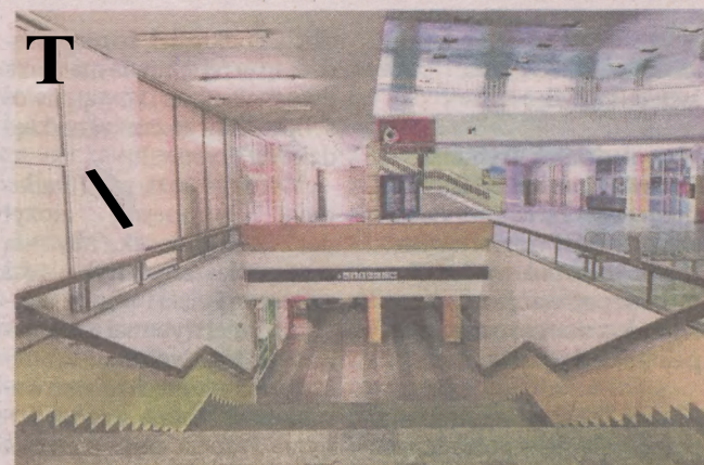
Powstanie tunel łączący PKP z osiedlem Zatorze
