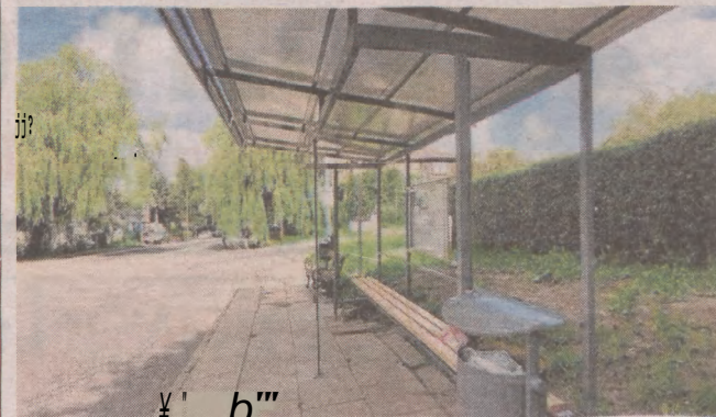
Czytelnik krytykuje wygląd nowej wiaty przystankowej przy ul. Gdyńskiej w Słupsku. Zarząd Infrastruktury Miejskiej odpowiada, że montaż wiaty nie został jeszcze zakończony. Przystankowe elementy przeniesiono z ulicy Konarskiego. Szyby będą dodane
