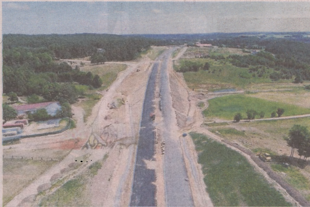
Wkrótce podpisanie umowy z wykonawcą 22-km odcinka dwujezdniowej drogi ekspresowej
