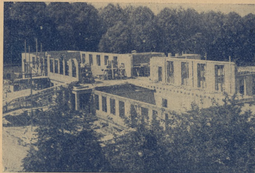
Fragment budowy nowej szkoły w Złocięcu
