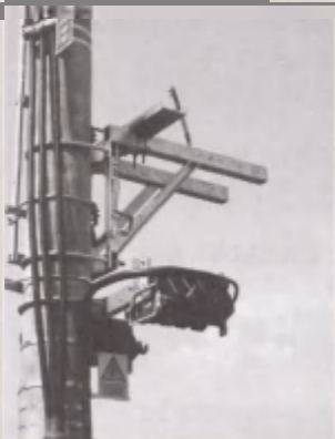
Конструкция под трансформатор и разъединитель.
