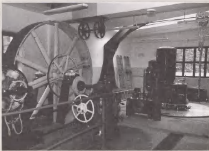
Историческая часть силовой установки гидроэлектростанции после модернизации.
