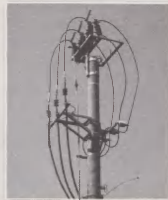
Конструкция под столбовую трансформаторную станцию.
