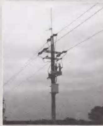
Конструкция под радиоуправляемый разъединитель 15 кв. с молниеотводом.
