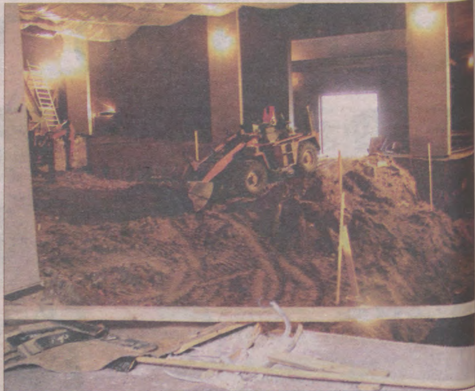
Na remontowanej widowni wykopano dziurę na głębokość jednego piętra.
