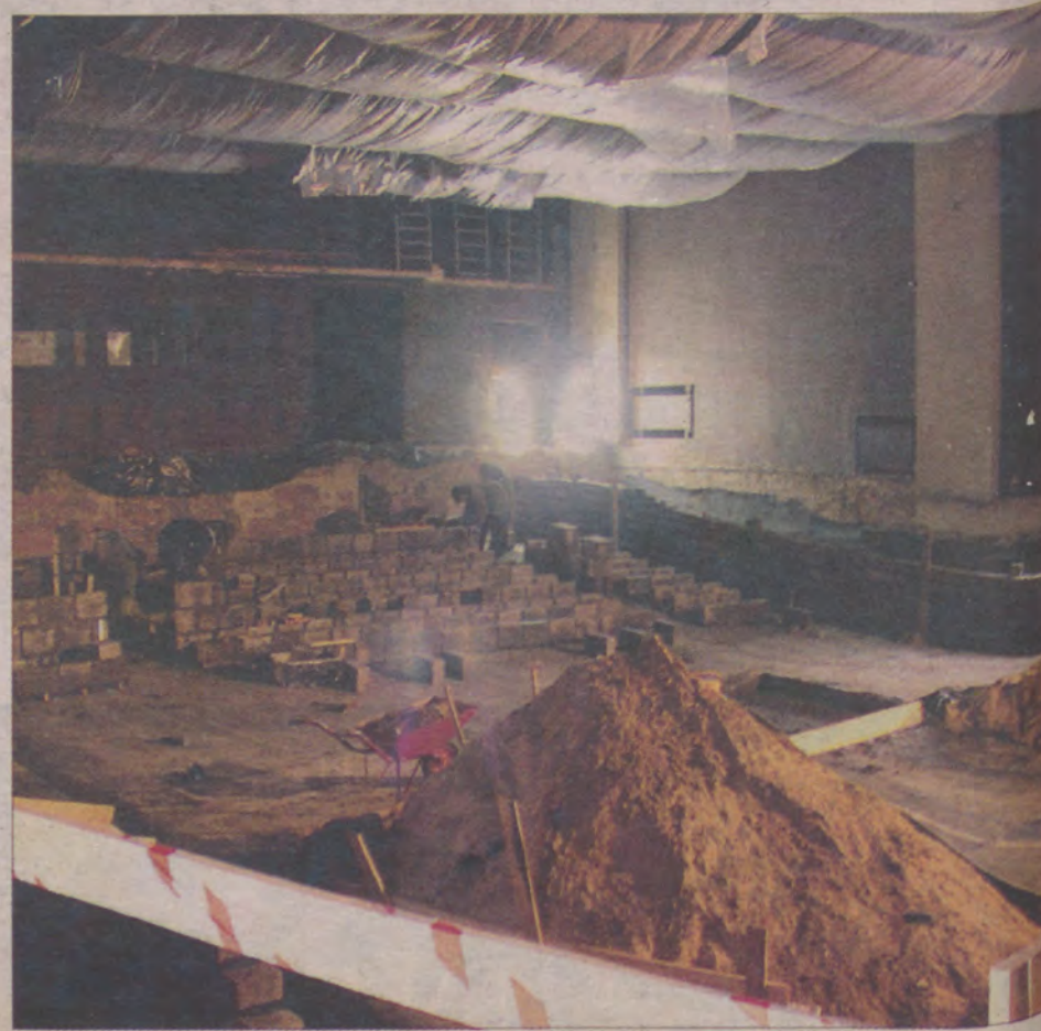
Najbardziej zmieniła się widownia. Zlikwidowano m.in. ostry spadek podłogi.
