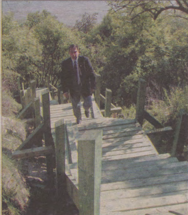
Wkrótce powstanie przejście z ul. Żeromskiego do schodów na plażę.
