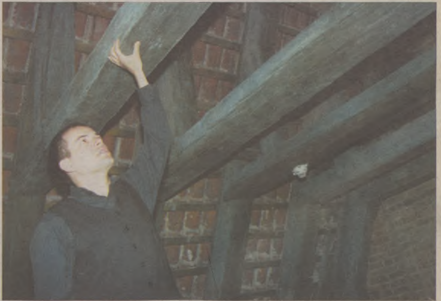
Ksiądz Wawrzyniec Ciesielski pokazuje część zabytkowej więźby dachowej.
