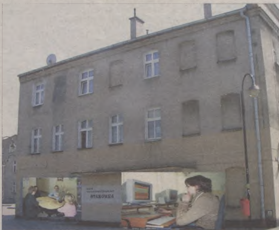
W budynku przy ul. Łaziennej w Tczewie już wkrótce pomoc znajdą osoby poszukujące pracy.
