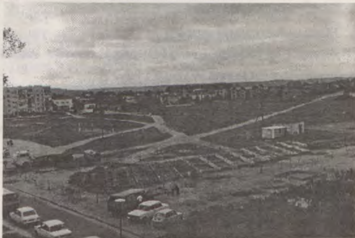
Fundamenty już zalane
