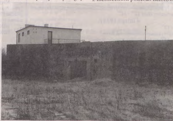
Bunkier w którym Niemcy składowali bomby. Obecnie ul. Tysiąclecia
