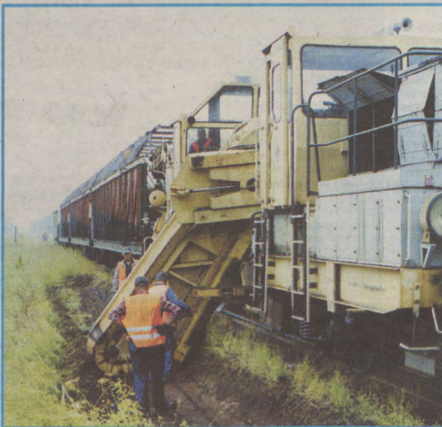
Na trasie kolejowej między Sławnem a Darłowem pojawiły się już ekipy remontowe.
