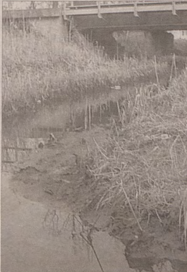
Struga Darłowska ma służyć jako kolektor sanitarny do odprowadzania oczyszczonych ścieków z oczyszczalni w Żukowie Morskim.
