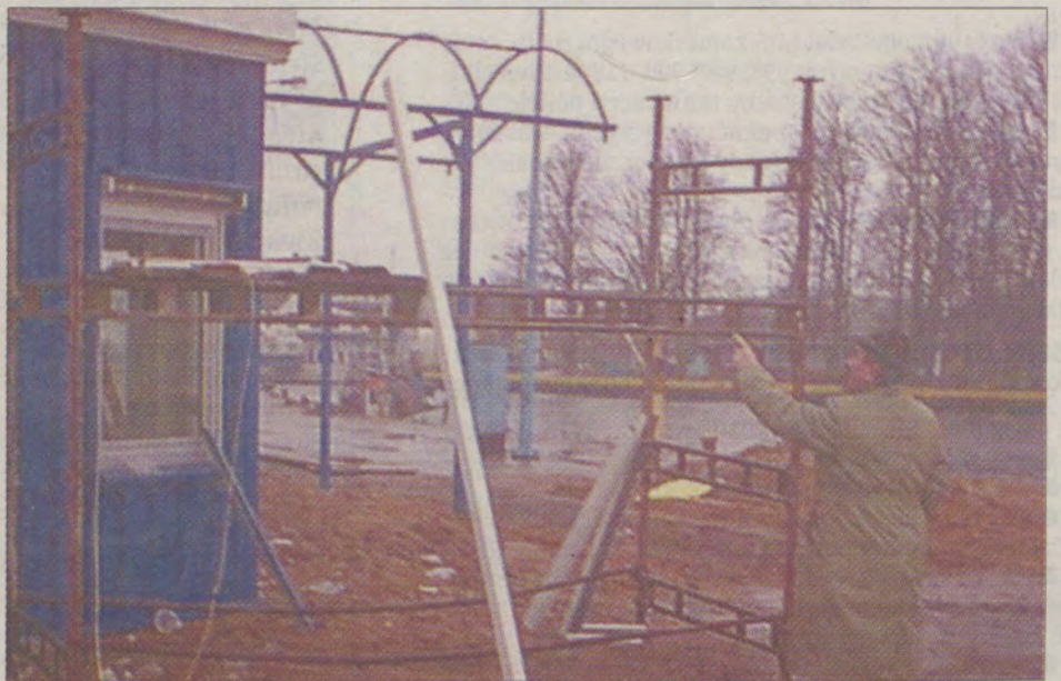
Leszek Walkiewicz, rzecznik prasowy UM w Darłowie pokazuje ostatnie prace w przyszłym terminalu.
