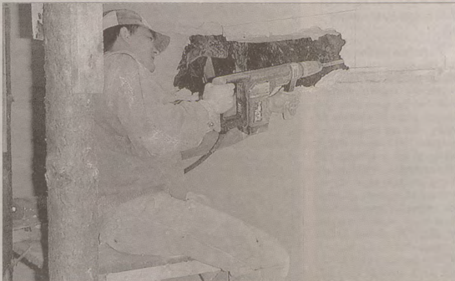
Jedną z największych inwestycji w gminie Sztum będzie dokończenie modernizacji budynków na potrzeby Szkoły Podstawowej nr 2. Na zdjęciu: Marek Dąbrowski z PBR Przyszłość wykuwa otwory na nową instalację elektryczną.
