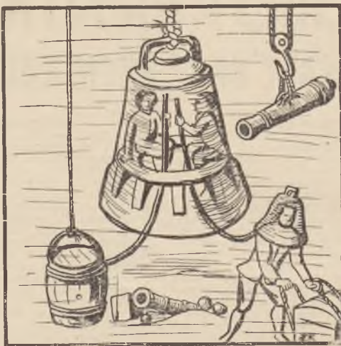
Dzwon podwodny oraz aparat indywidualny używane w końcu XVII wieku do wydobywania z dna zawartości zatopionych statków.
