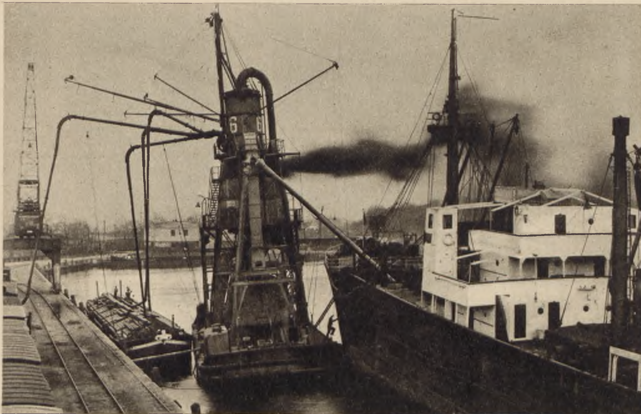
Gdańsk — pływający elewator zbożowy
