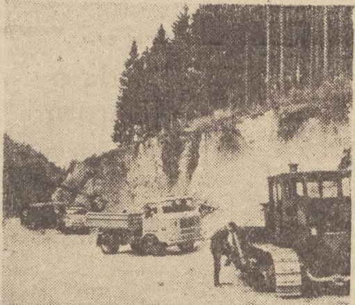
Pomiędzy Polanicą a Kodową trwają prace przy regulacji i modernizacji miedzynarodowej drogi E-12. Będzie mniej ostrych zakrętów, łagodniejsze spadki — słowem będzie bezpieczniej. CAF — Okoński
