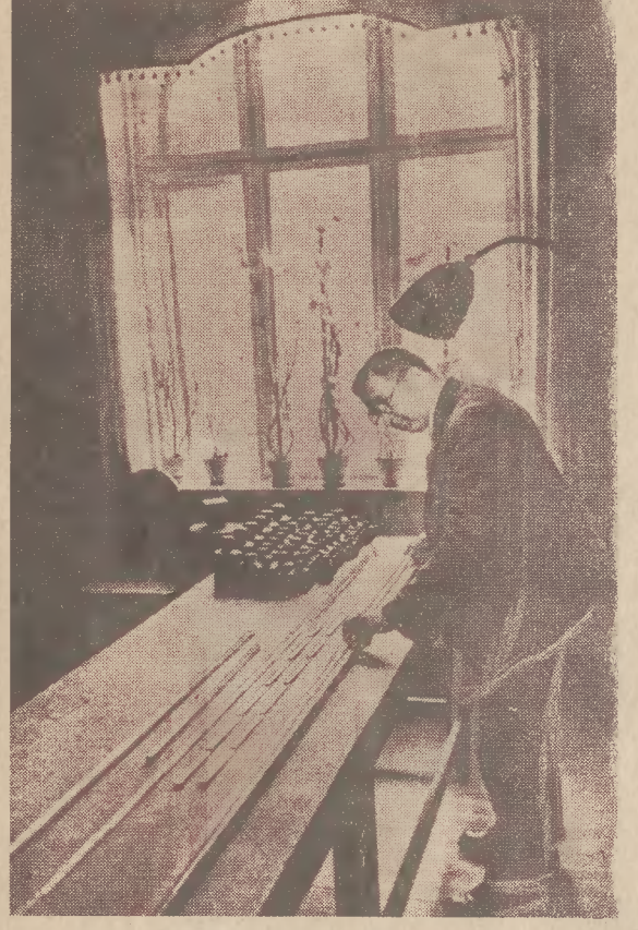
Ein Meter-Maß (Zollstock) von zwei Meter Länge wird durch Vergleichen mit dem Normal-Maßstab aus Holz neu geeicht.
