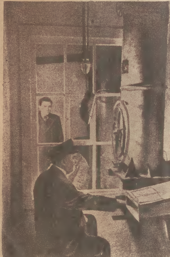
Die Eichung von Fässern. Auf dem Bilde links der Fassubzierapparat, auf dessen Scheibe der Inhalt des auf dem Bilde rechts volllaufenden Fasses abgelesen wird.
