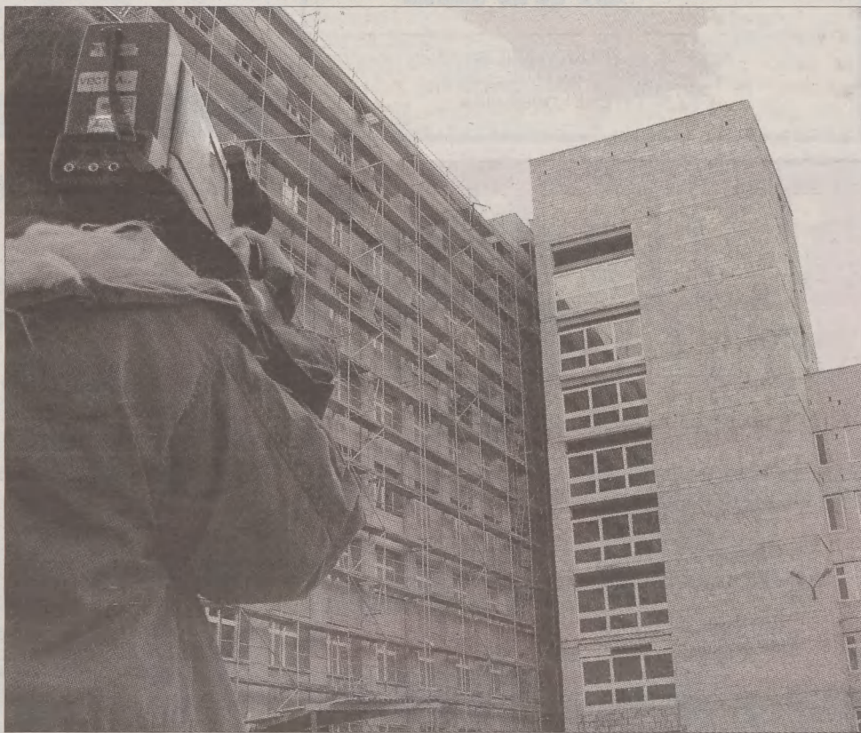
Szpital przy ulicy Hubalczyków w Słupsku budowany jest od 1986 roku.
