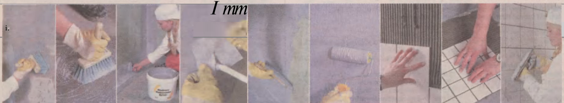
Aby zmniejszyć nasiąkliwość podłoża malujemy je dwukrotnie Impregnatem Optiroc Impregnat Optiroc nakładamy na dokładnie oczyszczone i osuszone powierzchnie Szczególnie ważne jest dokładne uszczelnienie naroży. Wykonujemy je za pomocą Membrany Wodoszczelnej Optiroc oraz Tkaniny Wzmacniającej Optiroc Wszystkie instalacyjne uszczelniamy dokładnie za pomocą Membrany Wodoszczelnej Optiroc oraz Tkaniny Wzmacniającej Optiroc Nałożenie Membrany Wodoszczelnej Optiroc jest bardzo proste Membranę Wodoszczelną Optiroc rozprowadzamy na powierzchniach równomiernie, warstwą o grubości 0,8-1 mm Do układania płytek ceramicznych możemy przystąpić po upływie co najmniej 2 dni od wykonania warstwy izolacyjnej z Membrany Wodoszczelnej Optiroc Płytki ceramiczne przyklejamy za pomocą elastycznej zaprawy klejącej, uważając przy tym, aby nie uszkodzić warstwy membrany Przed przystąpieniem do fugowania (np. Spoiną Optiroc) warto mieć pewność, że płytki ceramiczne będą trwale zdołały przylegnąć do podłoża
