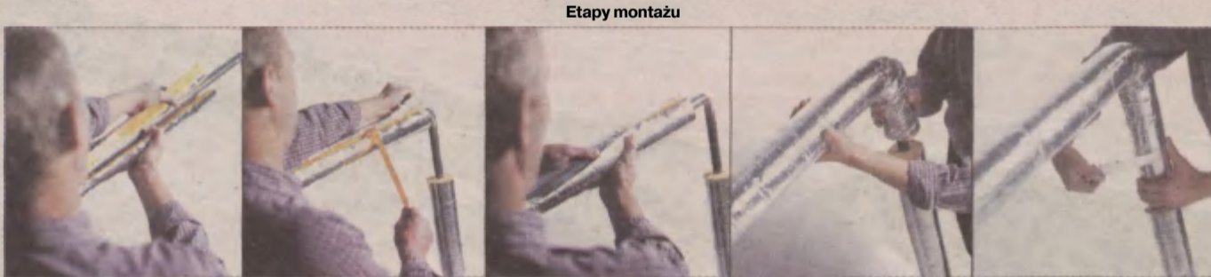
1. Załóż otulinę Isover BoaFlex na rurociąg.
