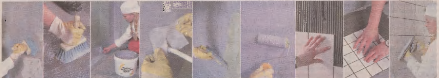
Aby zmniejszyć nasiąkliwość podłoża malujemy je dwukrotnie Impregnatem Optiroc. Impregnat Optiroc nakładamy na dokładnie oczyszczone i osuszone powierzchnie. Szczególnie ważne jest dokładne uszczelnienie naroży. Wykonujemy je za pomocą Membrany Wodoszczelnej Optiroc oraz Tkaniny Wzmocniającej Optiroc. Wszystkie przejścia instalacyjne uszczelniamy dokładnie za pomocą Membrany Wodoszczelnej Optiroc oraz Tkaniny Wzmocniającej Optiroc. Nałożenie Membrany Wodoszczelnej Optiroc jest bardzo proste. Membranę Wodoszczelną Optiroc rozprowadzamy na powierzchniach równomiernie, warstwą o grubości 0,8–1 mm. Do układania płytek ceramicznych możemy przystąpić po upływie co najmniej 2 dni od wykonania warstwy izolacyjnej z Membrany Wodoszczelnej Optiroc. Płytki ceramiczne przyklejamy za pomocą elastycznej zaprawy klejącej, uważając przy tym, aby nie uszkodzić warstwy membrany. Przed przystąpieniem do fugowania (np. Spoiną Optiroc) warto mieć pewność, że płytki ceramiczne będą trwale zdobyły ściany łazienki.
