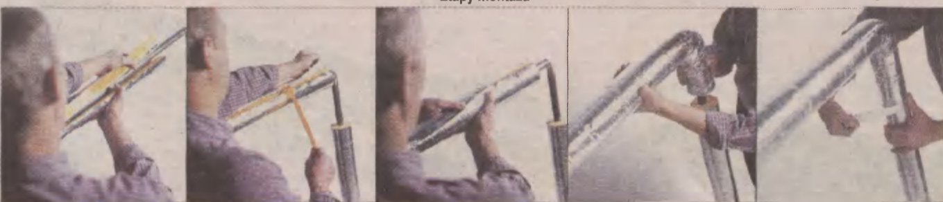
1. Załóż otulinę Isover BoaFlex na rurociąg.
