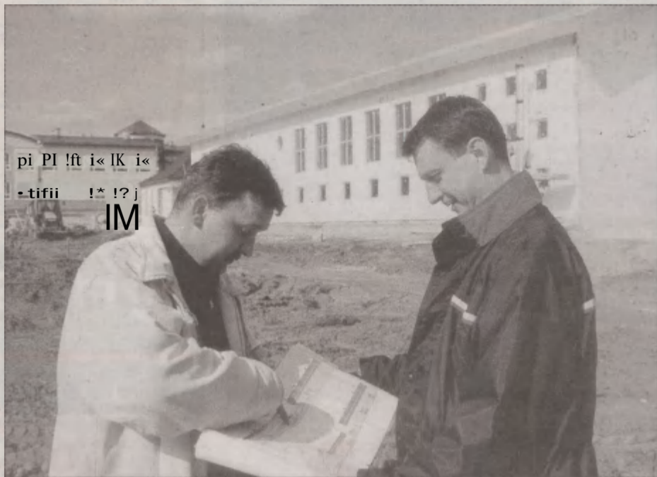
Przed nową halą sportową w Żukowie. Od lewej Wojciech Bobkowski, majster budowy, obok Grzegorz Szczygieł, kierownik budowy.
