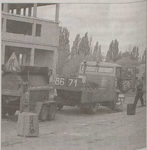
Kładzenie asfaltu to czasem syzyfowa praca.
