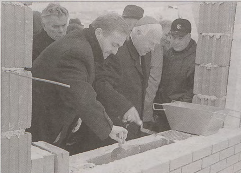
Prezydent Gdyni, Wojciech Szczurek i arcybiskup Tadeusz Gocłowski wmurowują kamień węgielny pod budowę hospicjum.
