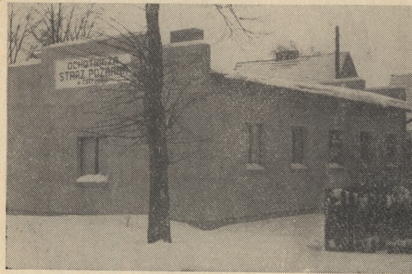
Na zdjęciu: remiza strażacka w Zakrzewie pow. Złotów. Wybudowano ją w czynie społecznym mieszkańców tej wsi z inicjatywy i przy czynnym udziale tutejszego komitetu Frontu Jedności Narodu. Wiejski Komitet FJN w Zakrzewie nie poprzestaje na dotychczasowych osiągnięciach i w planie działania na rok 1963 przewidział podjęcie wielu cennych przedsięwzięć zmierzających do podniesienia produkcji rolnej i realizacji czynów społecznych.
