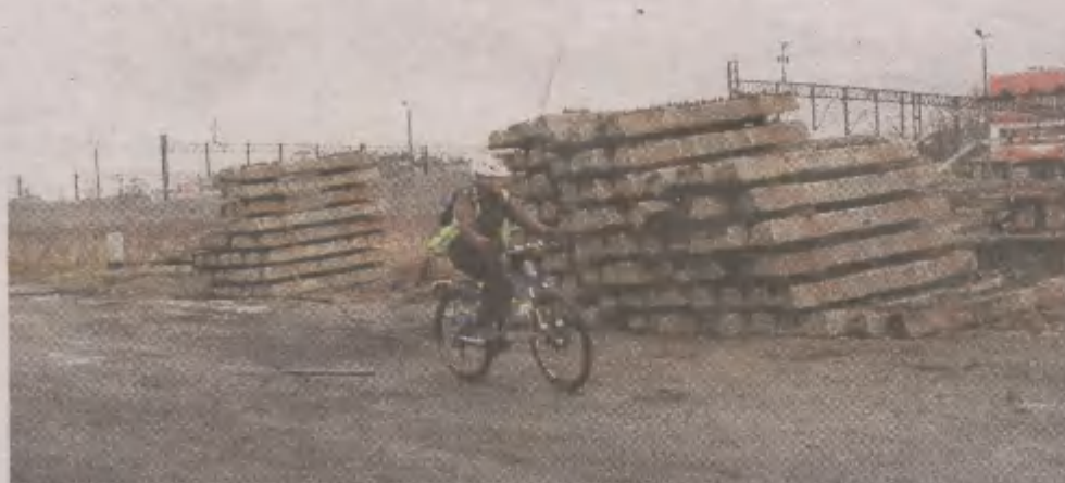
Składowiska na torowiskach pośrodku miasta przyciągają uwagę cyklistów z zacięciem
