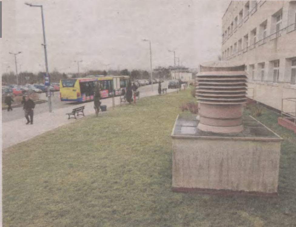
Autobusy MZK grzeją silniki tuż obok szpitalnej czepni powietrza. Miasto chce odwrócić trasę, i zachować przystanek, ale kosztem 23 miejsc parkingowych
