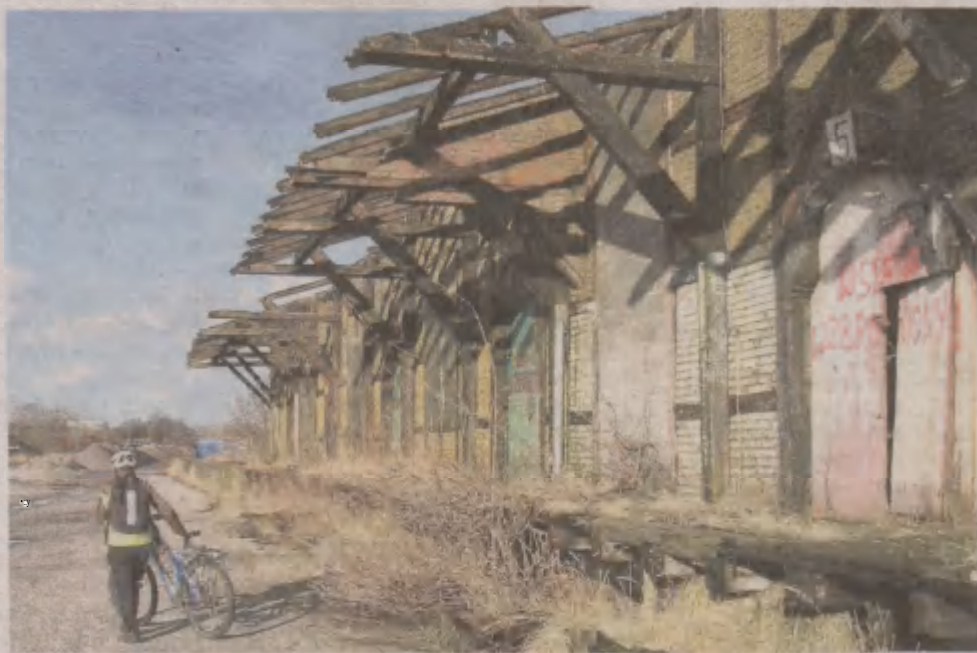
Nieczynna ekspedycja kolejowa, gdzie ma być węzeł komunikacyjno-przesiadkowy
