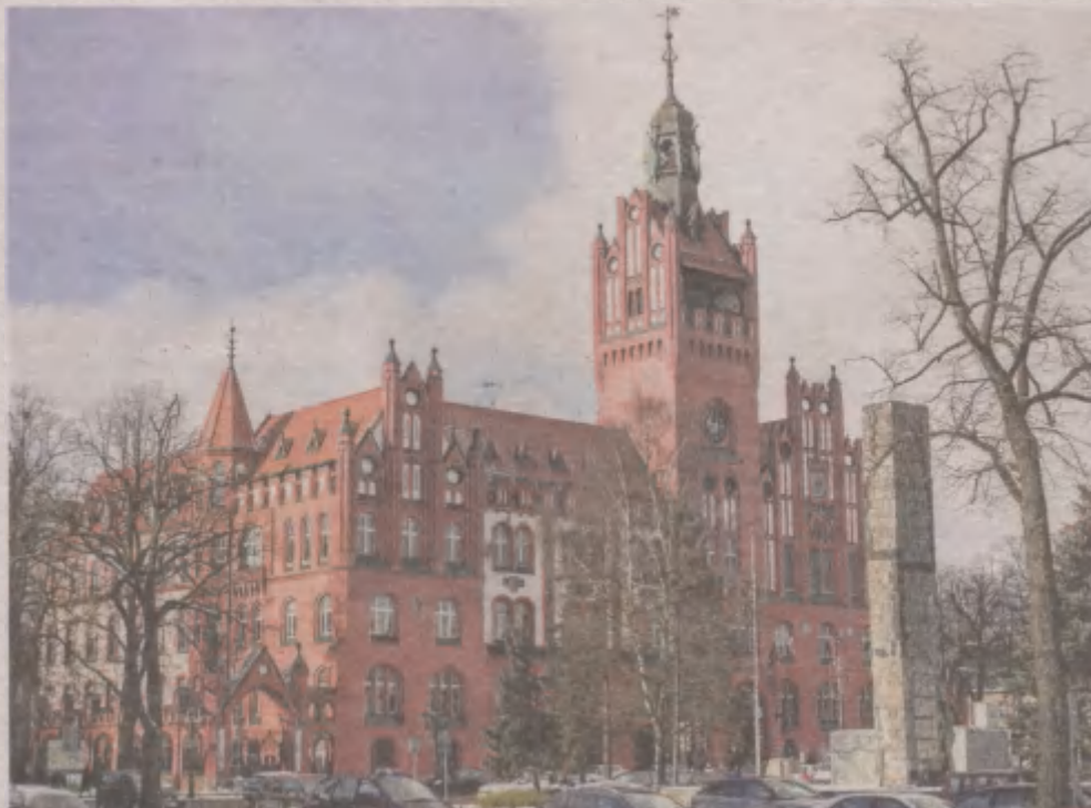
Prowadzony od ubiegłego roku remont słupskiego ratusza ma być ukończony w 2019 roku
