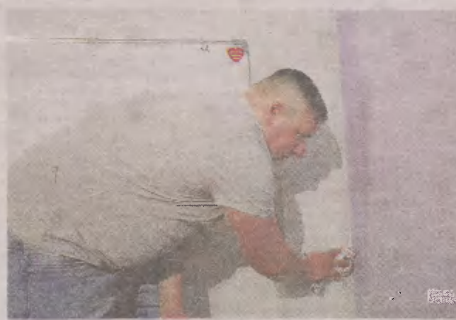
Pan Wojciech zabezpiecza ścianę w pokoju przed grzybem
