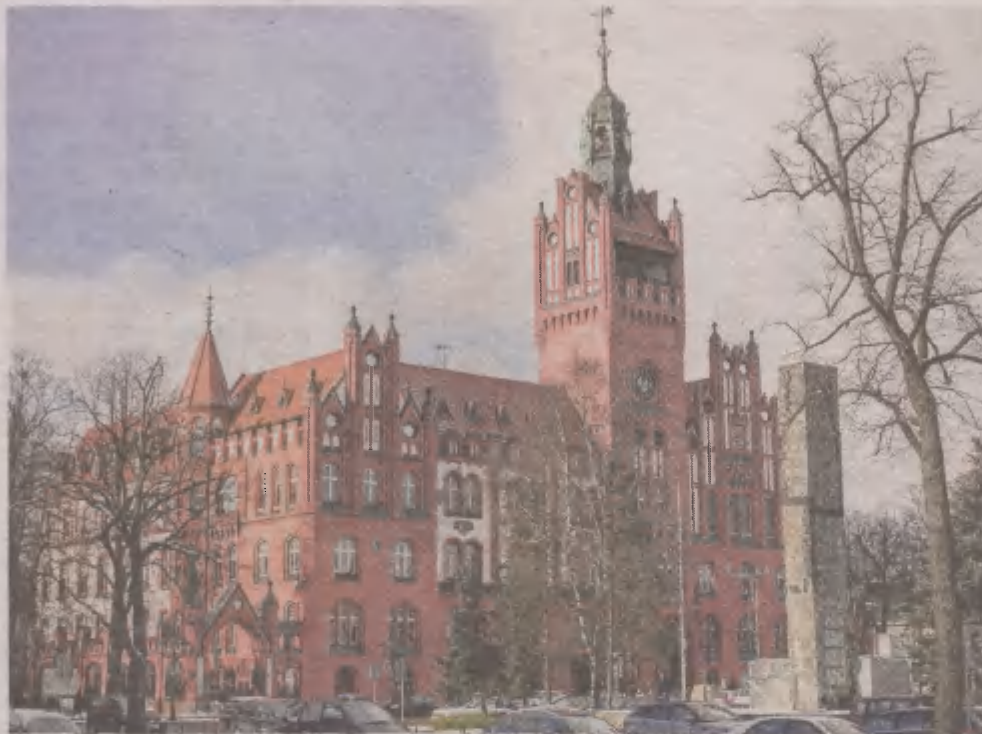
Prowadzony od ubiegłego roku remont słupskiego ratusza ma być ukończony w 2019 roku
