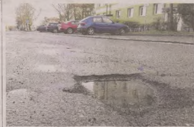
► Zarząd Infrastruktury Miejskiej zapowiada, że prace drogowe będą wykonane, jeśli tylko pozwoli na to pogoda
