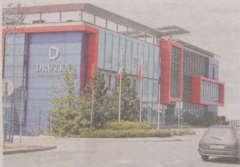
► Bytowski Drutex jest wiodącym producentem okien, drzwi i rolet w Europie. Na zdjęciu: biurowiec firmy przy ul. Lęborskiej w Bytowie
