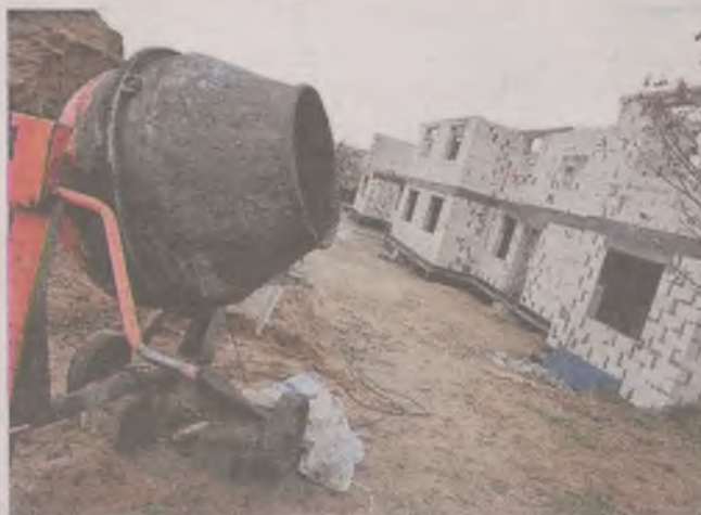
► Do końca roku zaplanowano wykonanie stanu surowego otwartego nowego budynku komunalnego w Kobylnicy
