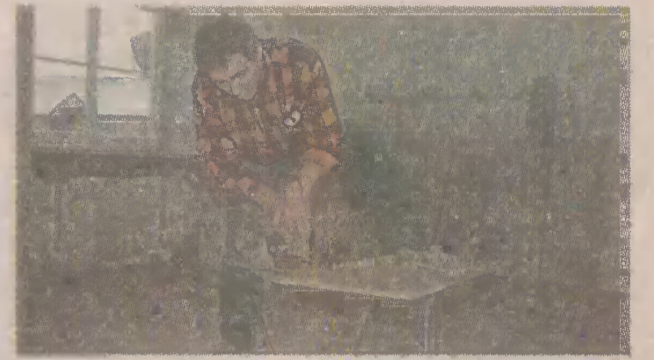
Dotowana była, m.in. modernizacja szpitala w Pastęku. Na zdjęciu, przy pracach remontowych, Jan Nowakowski.
