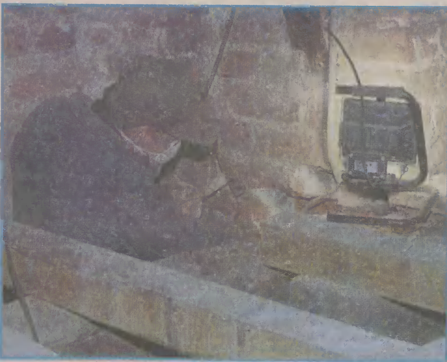
Paweł Błaszczak pracuje przy osuszaniu zabytkowych murów galerii. Fot. Aleksander Winter
